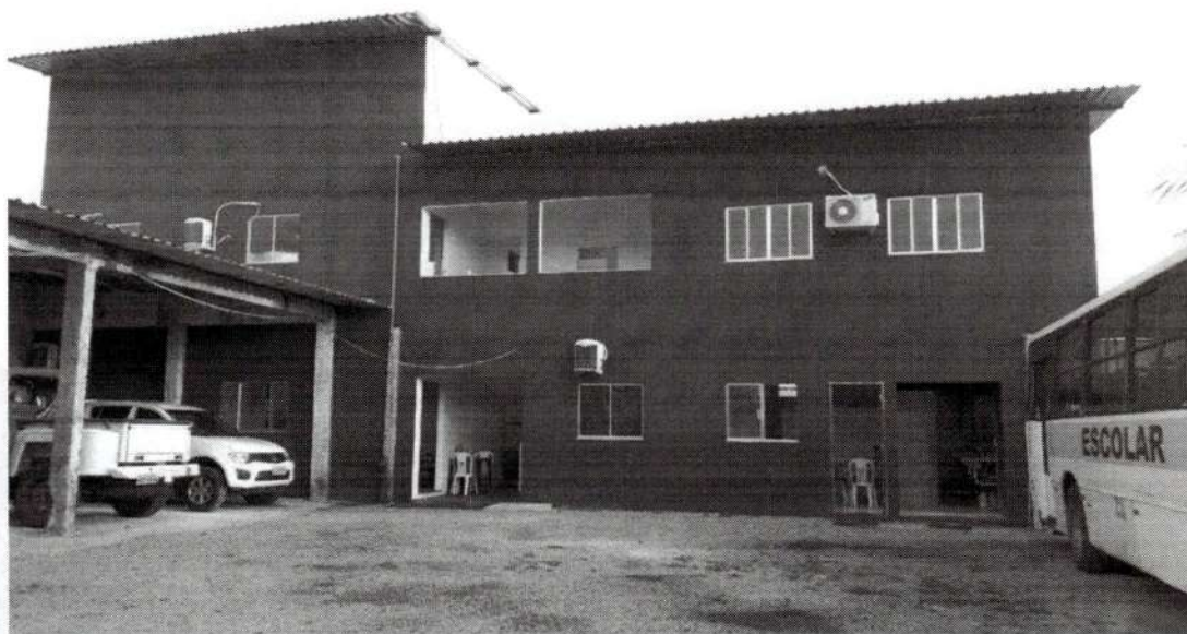
FOTO DA GARAGEM – ÁREA INTERNA DO MURO
