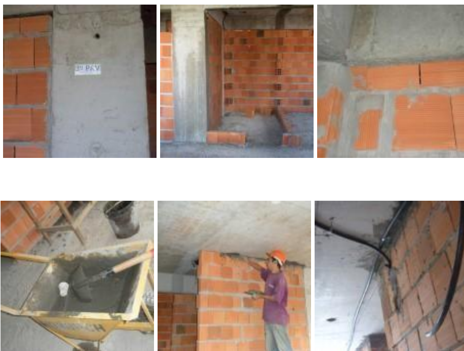
Execução do encunhamento de Blocos
